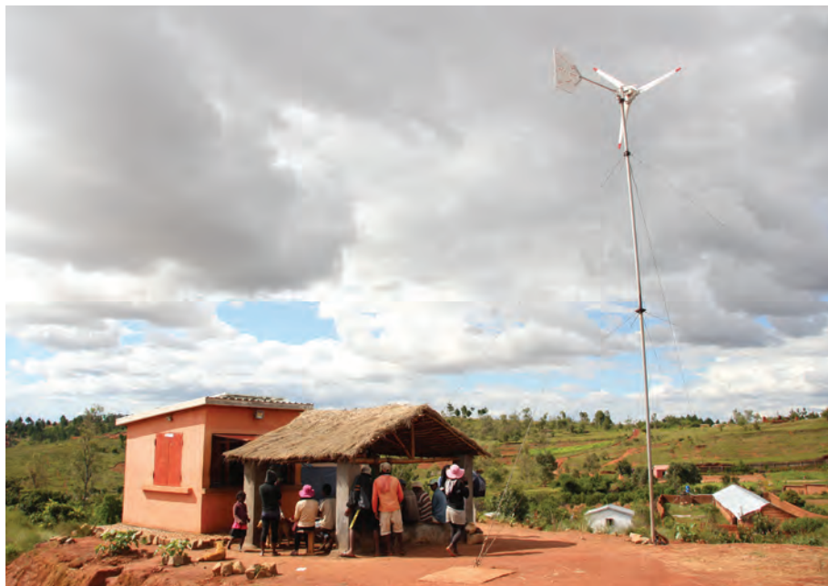
Le comité villageois d'Ambohitsilaizina a financé la construction d'un couvert pour augmenter l'attractivité de leur kiosque énergétique. (photo : P. Kohler/ CEAS)
