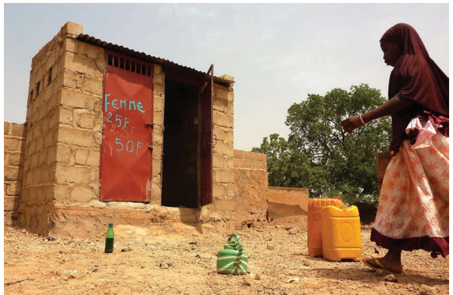
Auf dem burkinischen Markt in Saaba wurden am Ort einer ehemaligen Müllhalde Toiletten aufgebaut. (Foto: P. Kohler / CEAS)
