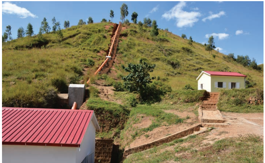
En contre-bas s'érige la centrale hydroélectrique qui fournira, dans un premier temps, de l'électricité à 375 ménages et une vingtaine de micro-entreprises (photo: D. Schneider)
