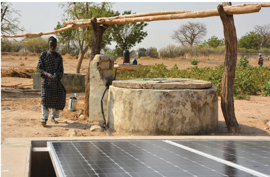
Utilisation de l'énergie solaire pour le pompage d'eau pour le maraîchage (photo : D. Schneider)
